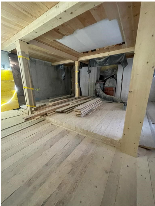
Archivräume im EG und OG
