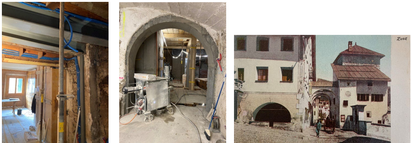
Stahlträger und Betonrundbogen zur Stabilisierung des Hauses
